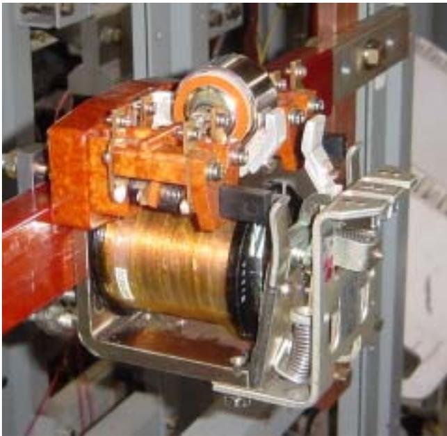
電磁接触器 正面写真（当該品）
