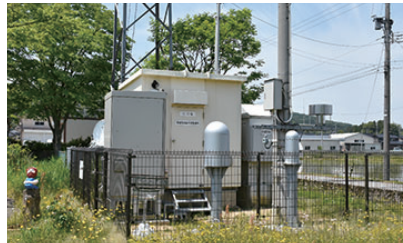
環境放射線観測局 (末坂局：中能登町(地図下線)) 空間放射線や風向、風速などを測定しています。
