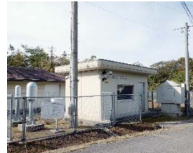
環境放射線観測局 (五里峠局：志賀町(地図下線)) 空間放射線や風向、風速などを測定しています。
