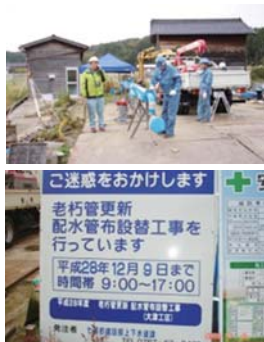
非破壊検査作業の状況
