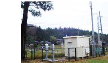
環境放射線観測局(大福寺局) 空間放射線や風向、風速などを測定しています。
